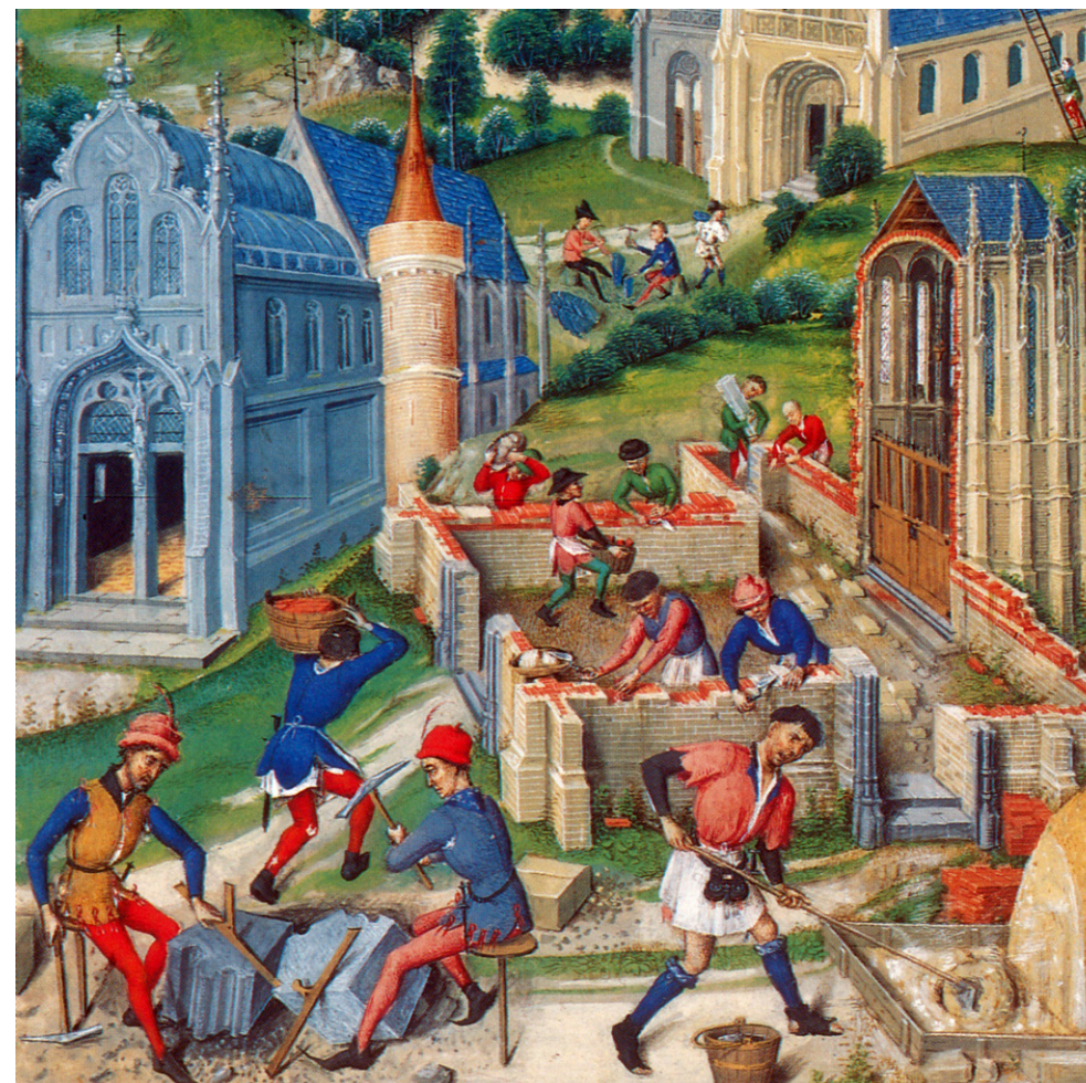
Manuscrit enluminé du Chronique Girart Roussillon illustrant la construction d'une église de France, 1448.
